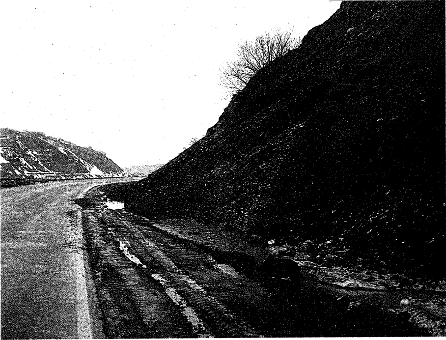
Şekil 4.3- Şev Dökülmesi
