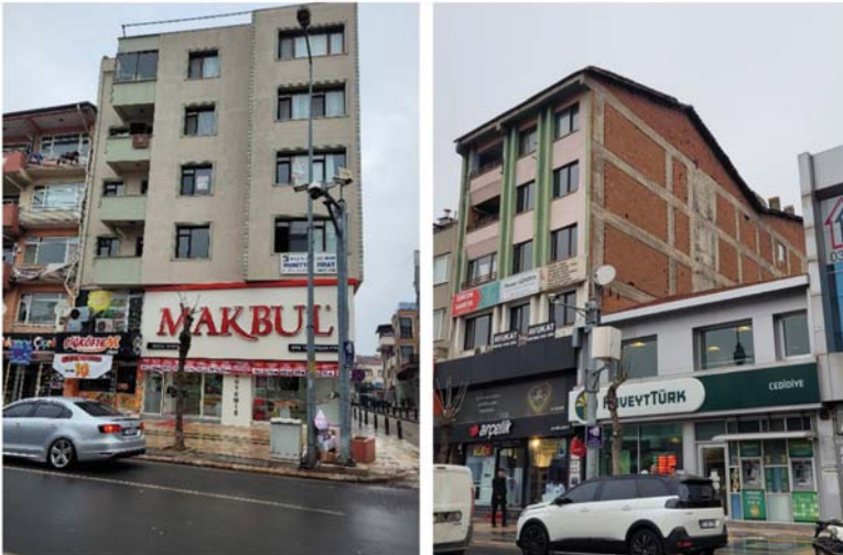
Şekil 14 - Güçlendirilmiş binaların Gölyaka depremi sonrası durumları
