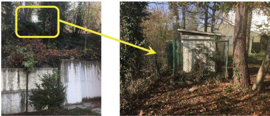
Şekil 6 - 8105 kodlu kayıt istasyonunun görünüşü
