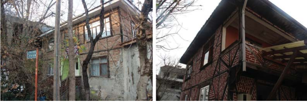
Şekil 13 - Hasarsız hımış bina örnekleri
